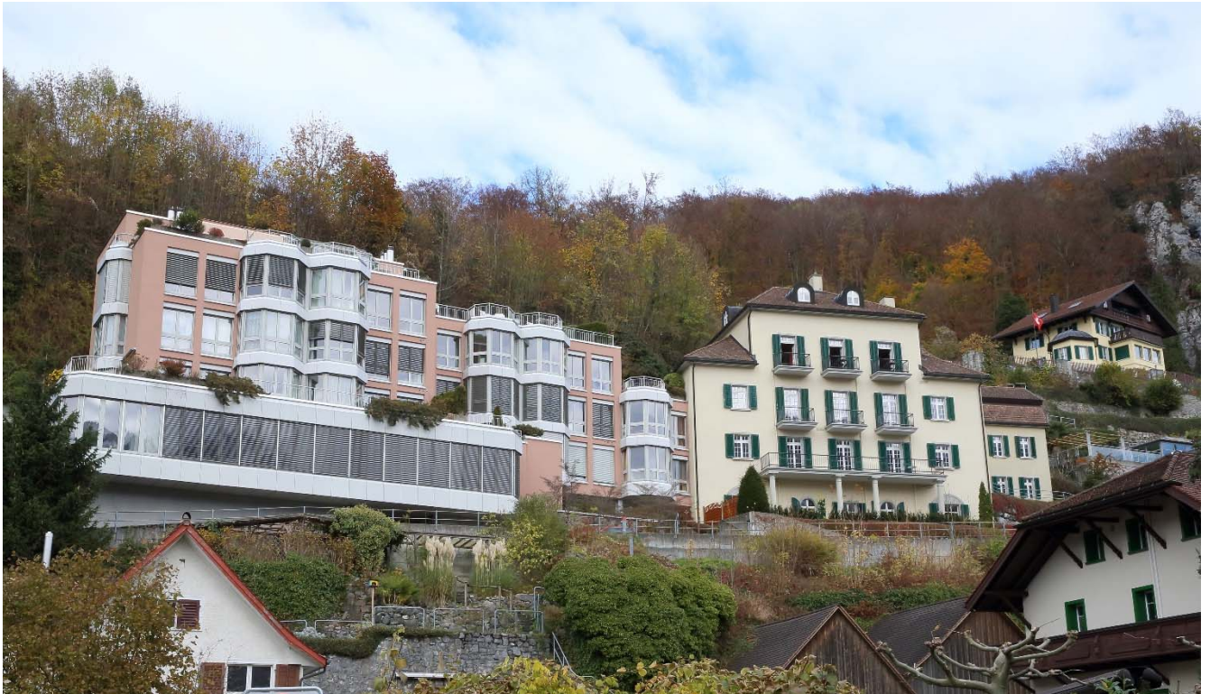
Die Mariahalde in Weesen mit 23 Eigentumswohnungen ist heizungstechnisch gesehen eine komplexe Liegenschaft.
