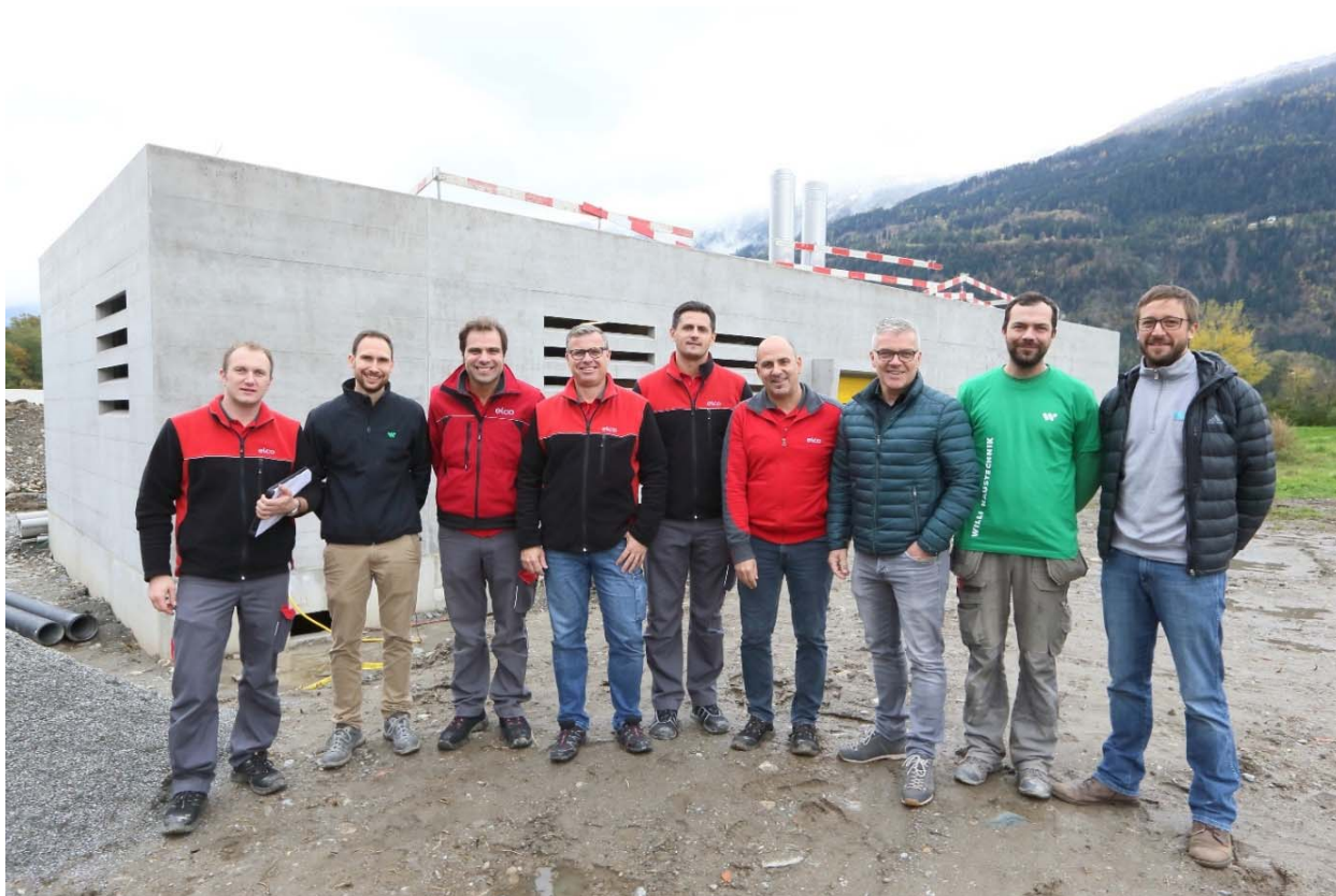
Foto di gruppo davanti alla costruzione grezza della centrale energetica lungo lo Schifflibach: (da sinistra) Michael Schmid (ELCO), Franco Roffler (Willi Haustechnik), Luigi Lavagna, Marcel Jaberg, Sabit Suljic, Jürg Denger, Kurt Willi (tutti ELCO), Semir Hero (Willi Haustechnik) e Florian Eigner (IBC).
