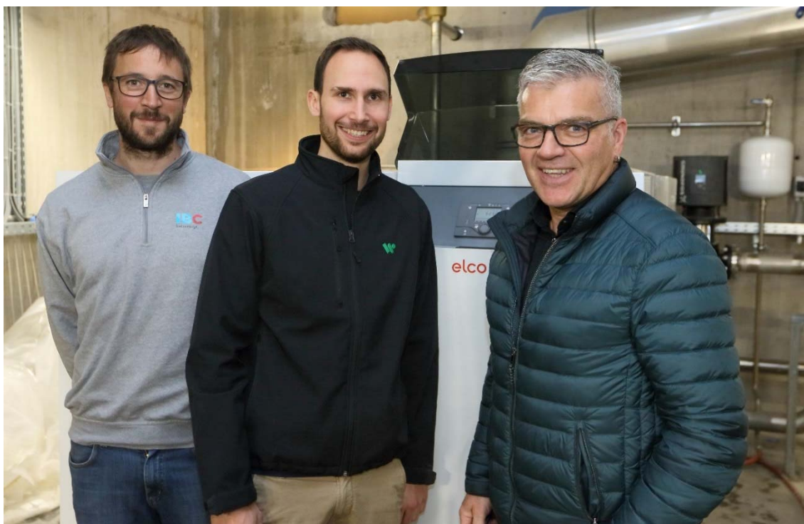
Da sinistra: Florian Eigner, capo progetto (IBC, Wärmeverbund); Franco Roffler, responsabile installazione (Willi Haustechnik AG); Kurt Willi, consulenza e vendita (ELCO).
