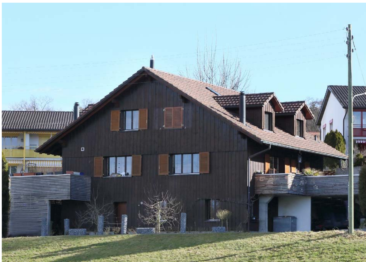
Le second circuit de chauffage a grandement amélioré le bien-être de cette maison familiale
