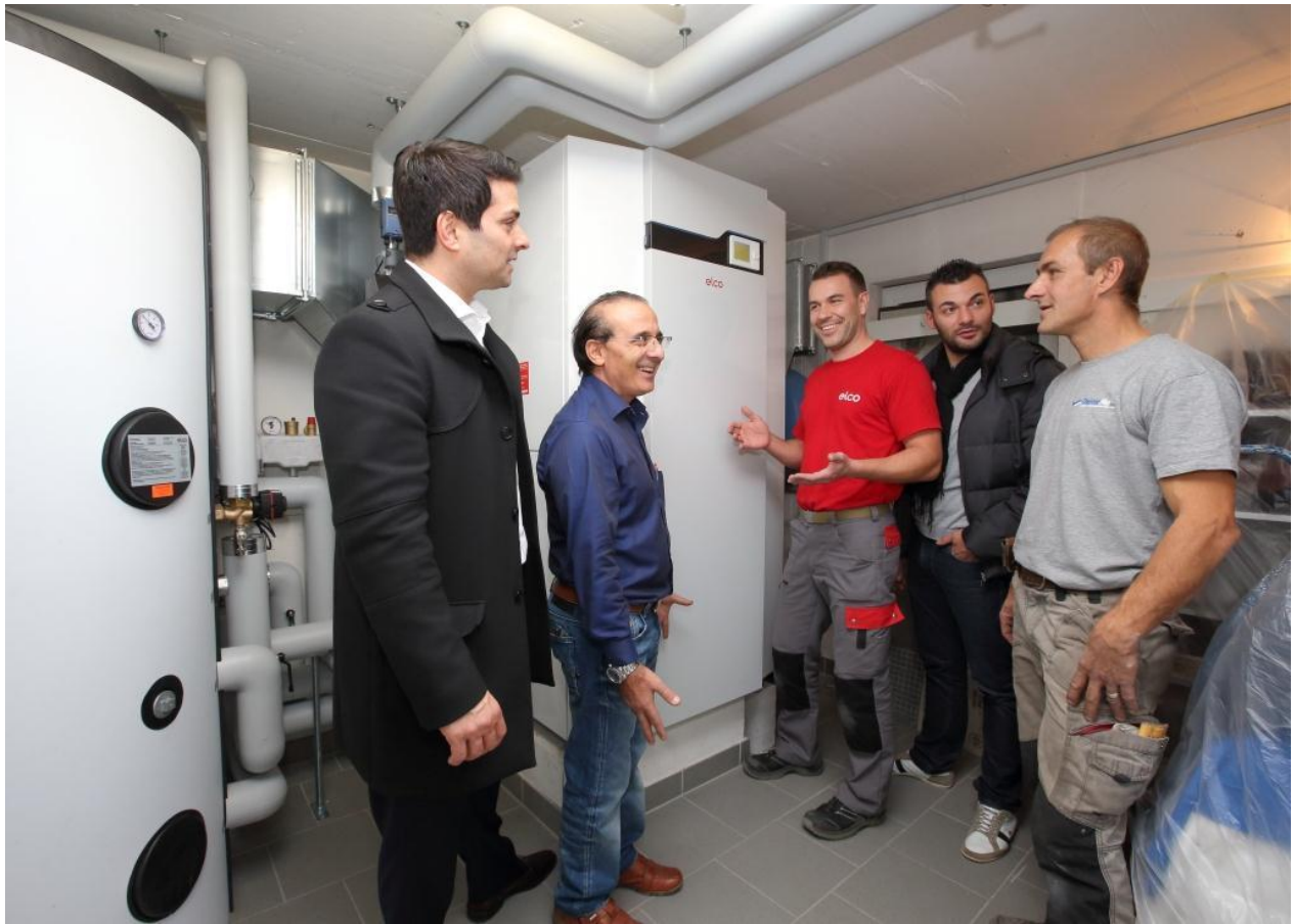
Ohne teamfähige Fachleute keine erfolgreiche Heizungserneuerung: Claudio Bertuca (2.v.l.) bei der Inbetriebnahme der Wärmepumpe mit den Hauptakteuren des Sanierungsprojekts.
