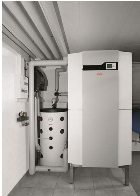
Bild 3: Für den Ersatz einer zentralen Elektrospeicherheizung bildet die AEROTOP S eine hervorragende Alternative, da der vorhandene Energieträger Strom weiter, jedoch viel effizienter genutzt werden kann.
