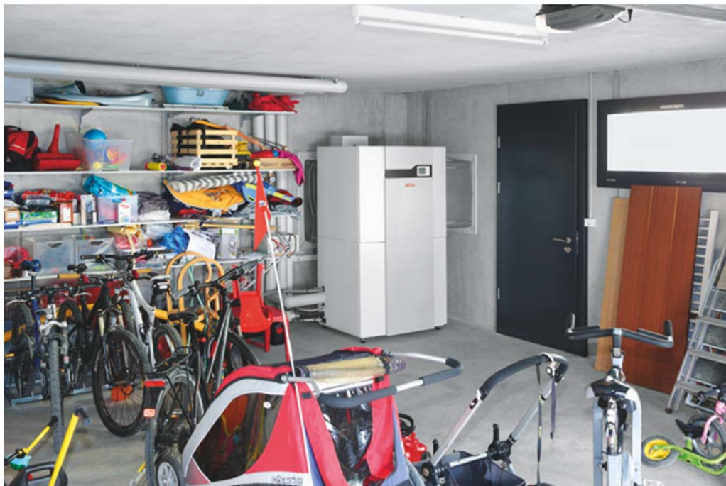
Bild 2: Die AEROTOP S mit 5 Leistungsgrössen von 5 bis 14 kW (A-7/W35) kommt im Neubau sowie in der Sanierung zum Einsatz. Dank kompakten Abmessungen braucht sie wenig Platz und lässt sich praktisch an jedem beliebigen Ort im Haus aufstellen.
