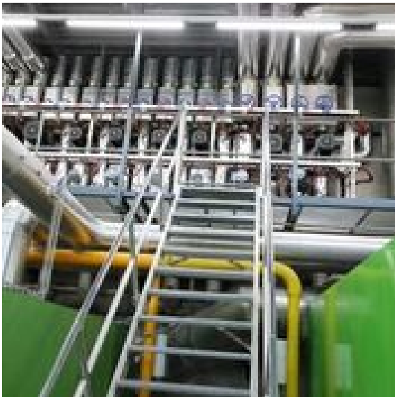
Im Rahmen der etappenweisen Erneuerung der Heizzentrale wurde in einem zweiten Schritt der Hochtemperatur-Verteiler saniert.
